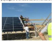
Photographie 5 : Montage des modules sur des supports fixes Source : EDF Renouvelables
