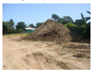
Exemple de décapage et mise en stock de terre végétale (Rémire-Montjoly, AGIR)
