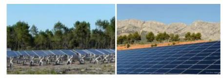
Photographie 1 : Structures solaires (à gauche: les trackers de la centrale de Gabardan (40) qui suivent le soleil ; à droite : structures fixes à Puyloubier (13)) - Source : EDF Renouvelables
